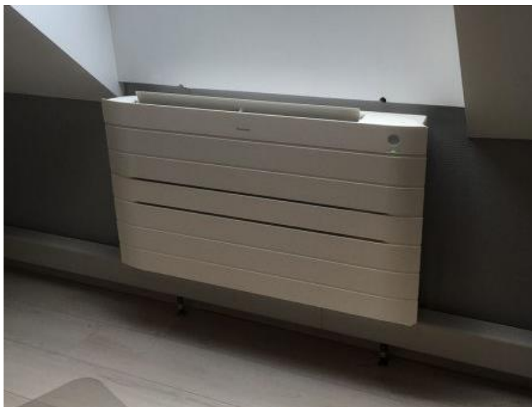
Εικόνα 43 Fan-coil
