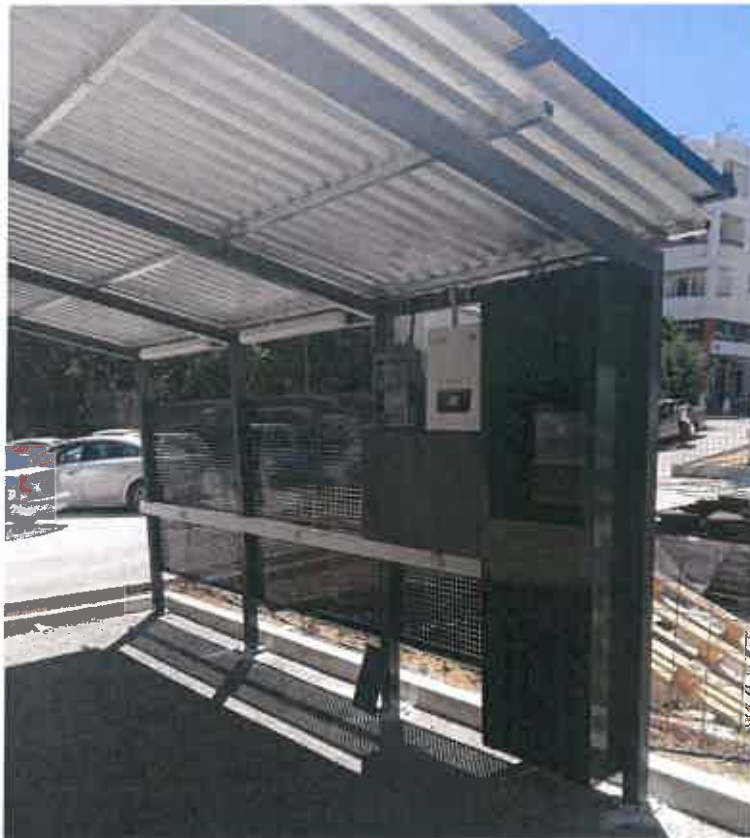
Εικόνα 61 Ενδεικτικός σταθμός ηλεκτρικών ποδηλάτων
