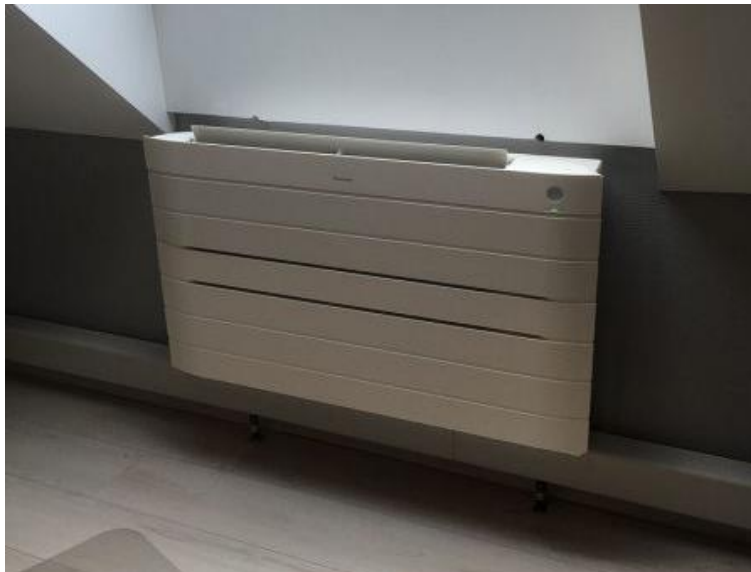
Εικόνα 43 Fan-coil
