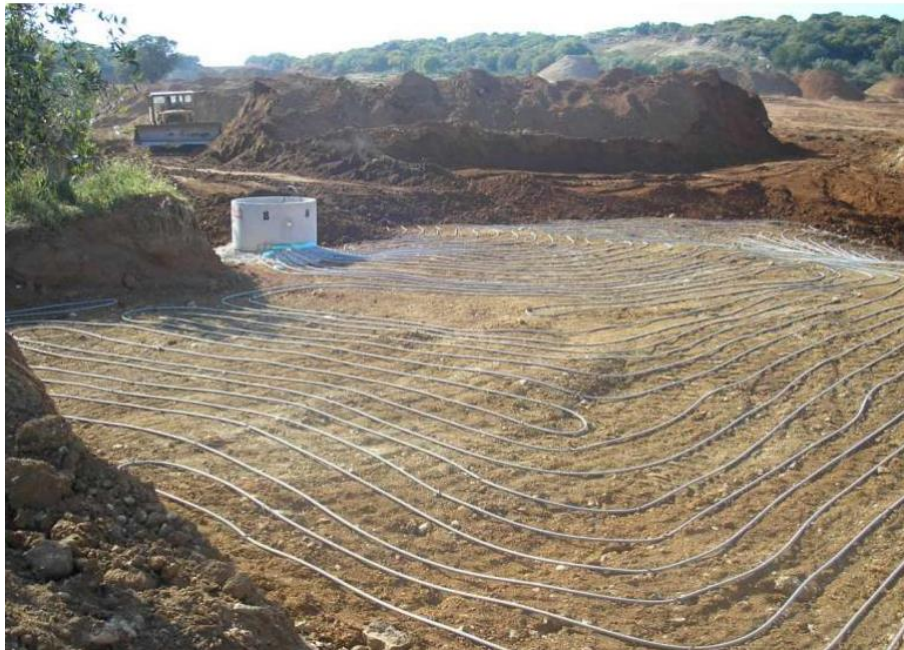
Εικόνα 48 Παράδειγμα οριζόντιας γεωθερμίας
