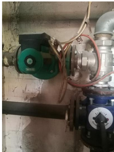
Εικόνα 24 Ο κυκλοφορητής
