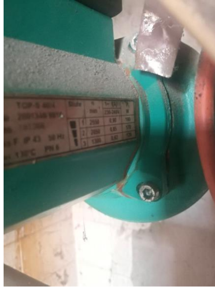
Εικόνα 25 Ο κυκλοφορητής
