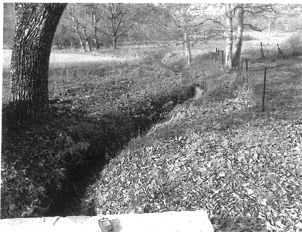
Φωτ.2 : Άποψη της περιοχής ανάντη του προβλεπόμενου φρεατίου 3.15 στη θέση υφιστάμενου τεχνικού επί της επαρχιακής οδού προς Κοτύλη
