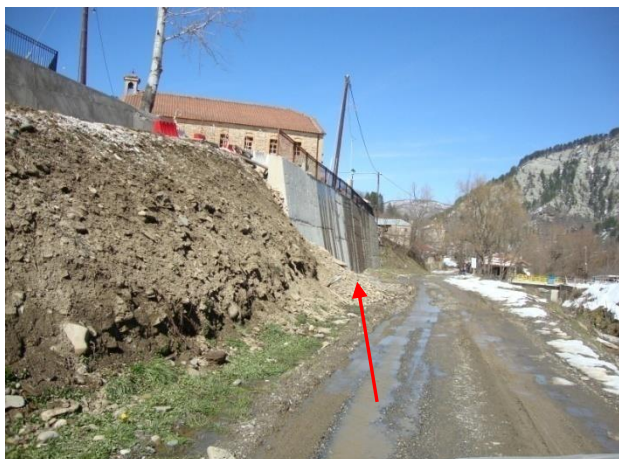
Εικόνα 12: Τοίχος αντιστήριξης στην περιοχή του οικισμού Πεύκος
